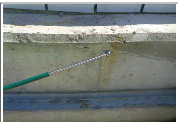
들뜸봉을 이용한 외관조사(타격음)
